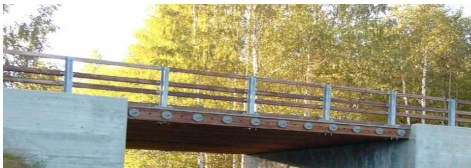
Рис.2. Mattisdammen Bridge (2000 г.). Предварительно напряженная клееная плита
