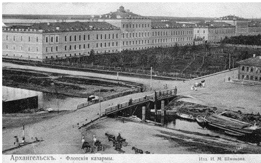
Рис. 2. Деревянный балочный мост через реку Соломбалку в Соломбале
