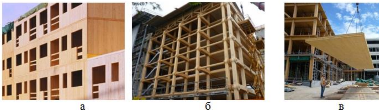
Рис. 1. Конструктивная система: а – панельная; б – каркасная; в – панельно-каркасная.
