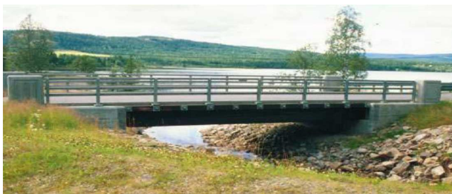
Рис.3. Givlla Bridge (1997 г.). Мост с деревоклееными балками
