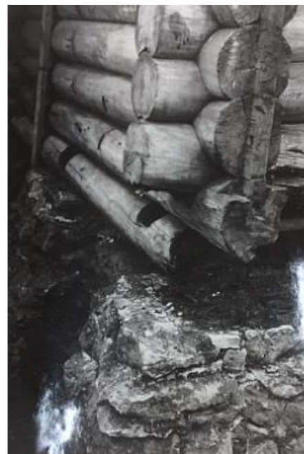
Рис. 2. Фрагмент опирания бревен придела северо-западной стороны на фундамент
