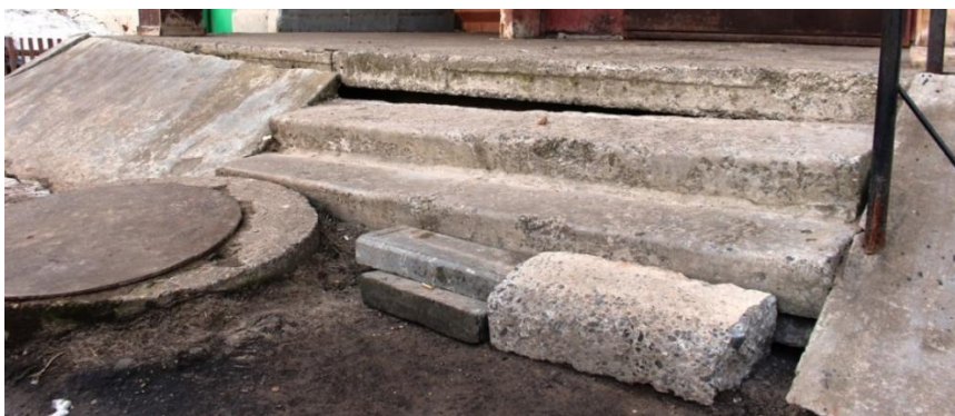
Рис. 1. Деформация крыльца девятиэтажного панельного здания вследствие неравномерных осадок торфа в основании
