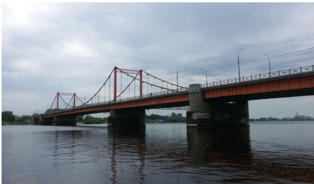
Рис. 3. Общий вид висячего моста через реку Кузнечиху
