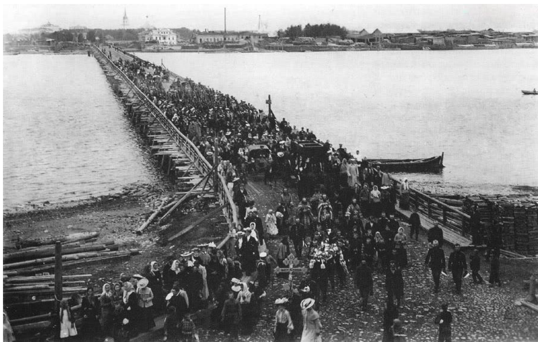
Рис.1. Деревянный мост через р. Кузнечиха
