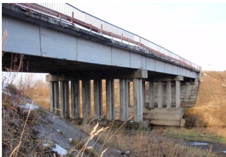
Рис.5. Деревожелезобетонный балочный мост через реку Лявлю в Архангельской области
