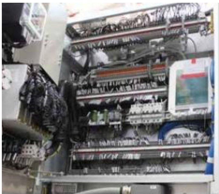
Рис. 1. Релейный отсек стандартной ячейки КРУ
