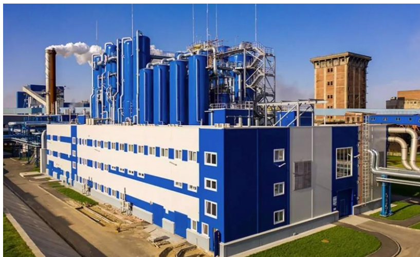
Вид здания со стеновыми панелями
