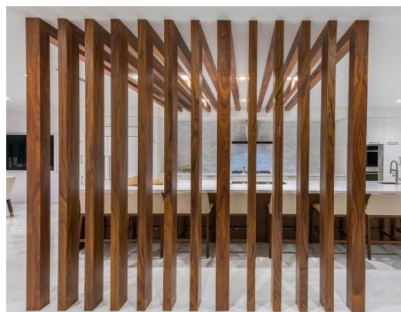
Рис. 3. Стеновые шпоновые рейки
