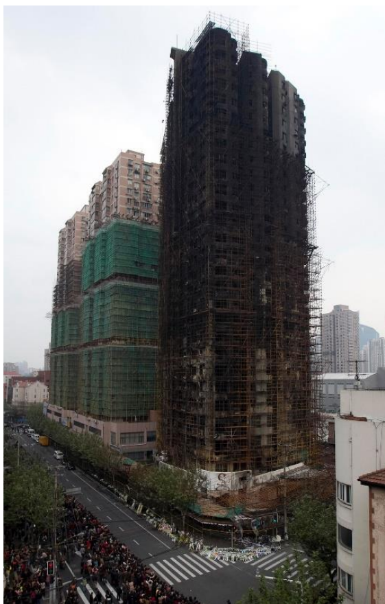
Рис. 1. Последствия пожара в Шанхае
