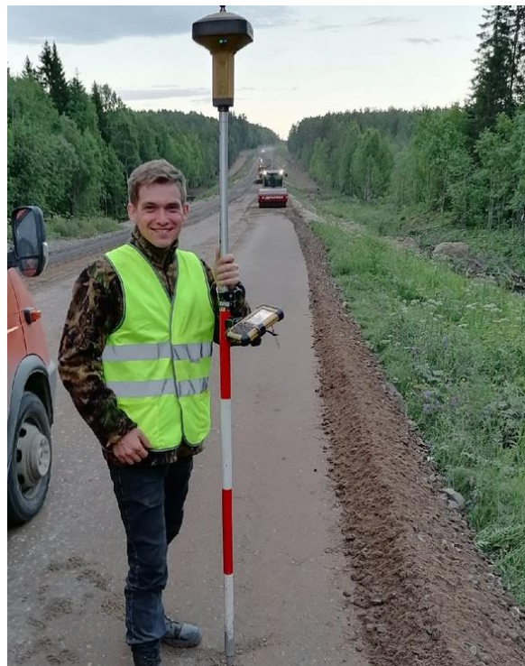
Рис. 2. Использование геодезического оборудования TOPCON на практике
