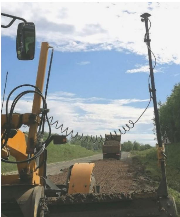
Рис. 1. Использование геодезического оборудования на грейдере
