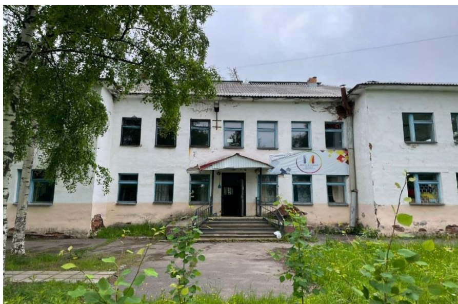
Рис. 1. Общий вид здания до реконструкции
