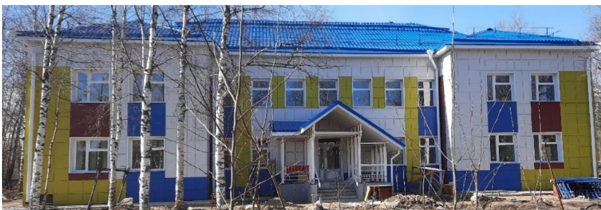
Рис. 2. Вид здания после проведения работ по утеплению ограждающих конструкций
