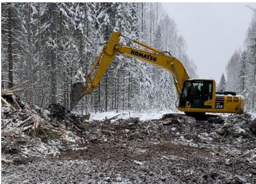
Рис. 1. Расчистка трассы от пней и порубочных остатков
