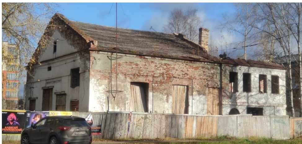
Рис. 1. Современное состояние здания трамвайной подстанции, 2022
