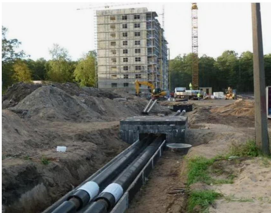
Рис. 2. Тепловая сеть
