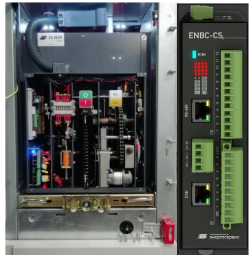
Рис. 2. Цифровой вакуумный выключатель с ENBC-CS
