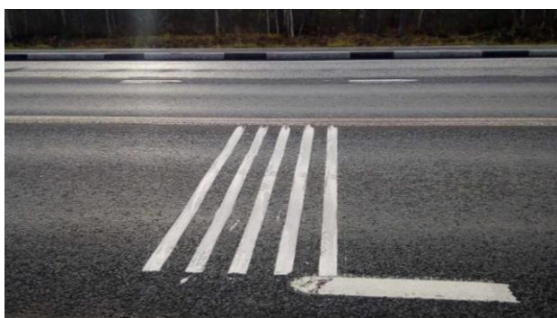
Рис. 1. Поперечные шумовые полосы в Архангельской области на подъезде к г. Северодвинск
