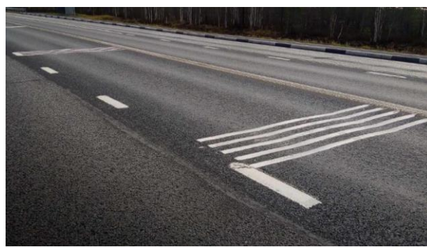
Рис. 2. Поперечные шумовые полосы в Архангельской области на подъезде к г. Северодвинск
