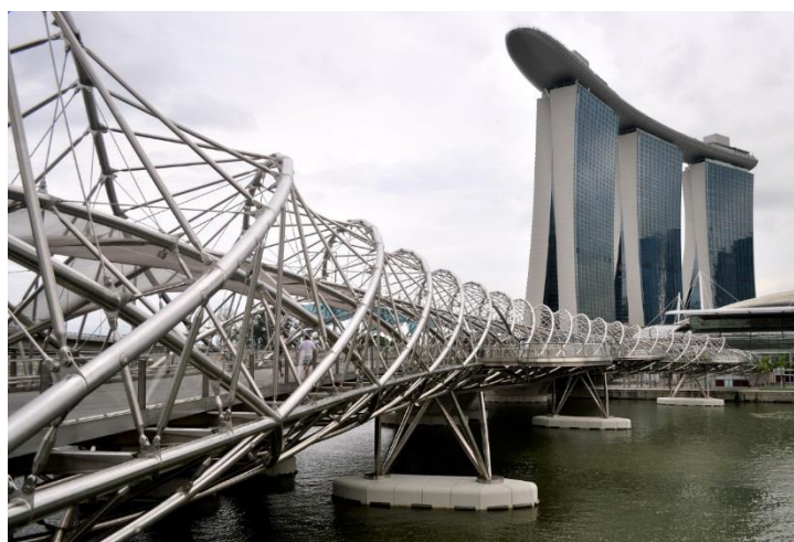
Рис. 2. Мост Хеликс Бридж (Сингапур) [3]
