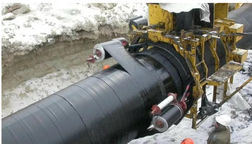
Рис. 1. Нанесение гидроизоляции на поверхность трубопровода
